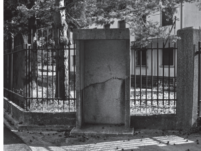
Figura 32. Garrita presso l'accesso della caserma Zucchi di Chiusaforte.
